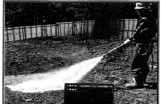
工事施工ヤード等の清掃、散水
